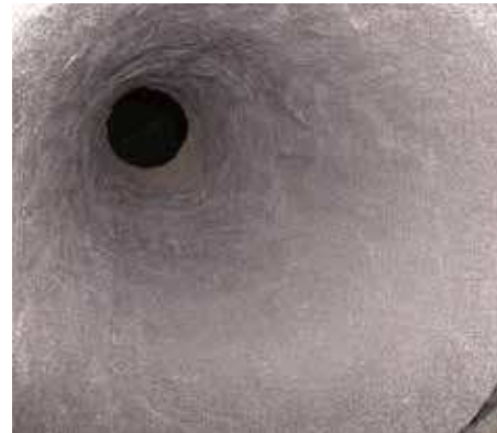
Oceľový kónus s naneseným materiálom Belzona 1812
