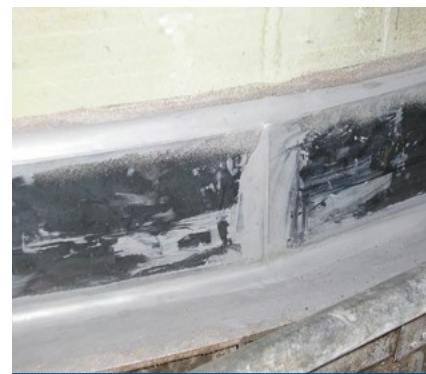
Lepenie platní systémom Belzona
