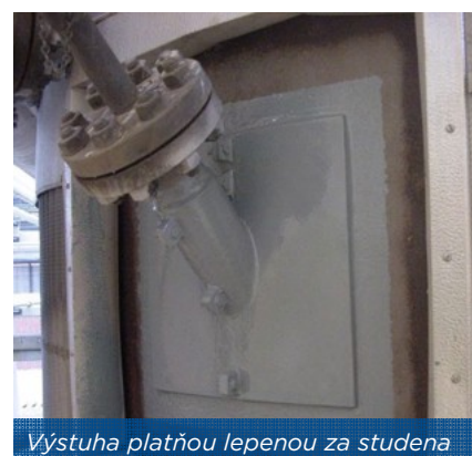
Lepenie platní systémom Belzona
