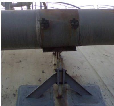
Lepené podpery potrubia
