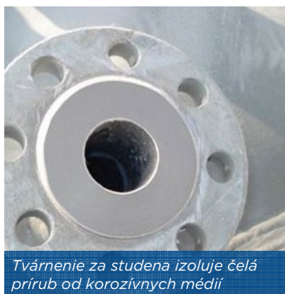
Povlak Belzona aplikovaný na novo vyrobenú procesnú nádobu
