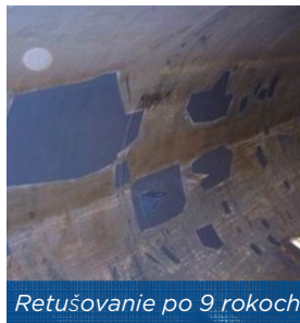
Oprava povlakom so sklenenými vločkami
