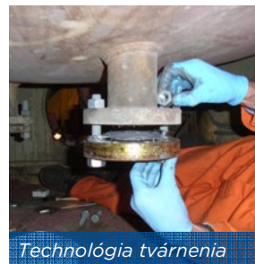
Oprava povlakom so sklenenými vločkami
