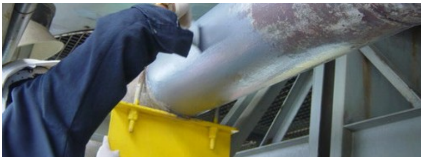
KPI riešenie aplikované na mieste na horúce kontaminované povrchy
