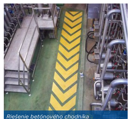
Okraje zatmelené, spoj Belzona inštalovaný
