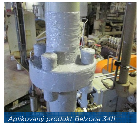
Aplikovaný systém Belzona SuperWrap II
