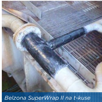
Aplikovaný systém Belzona SuperWrap II
