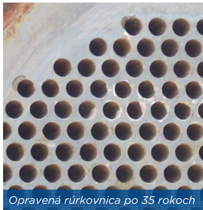
Hlava výmenníka opravená a chránená
