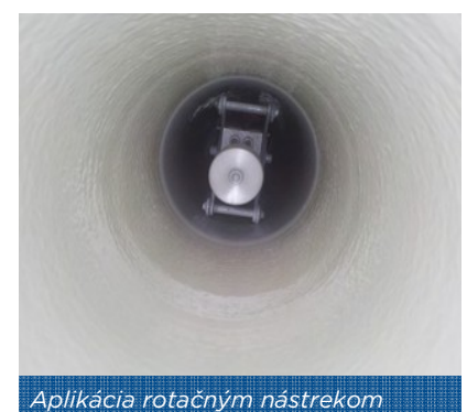
Obvodový zvar pokrytý jednou vrstvou
