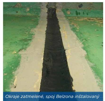
Podložka Belzona zaisťuje nádobu
