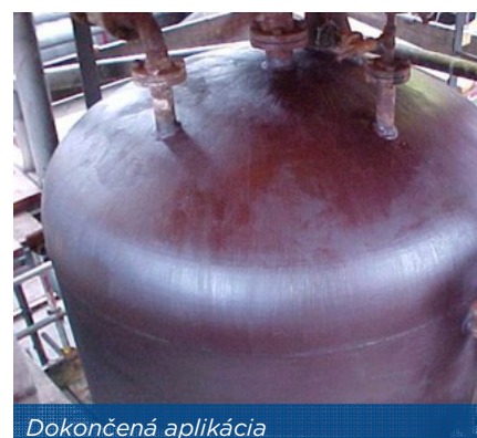
KPI riešenie aplikované na mieste na horúce kontaminované povrchy
