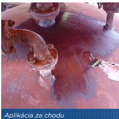
KPI riešenie aplikované na mieste na horúce kontaminované povrchy
