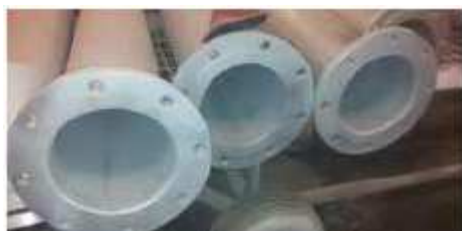
Pred aplikáciou, počas aplikácie a po aplikácii systému Belzona 1381 striekaním na vnútorný povrch potrubia
