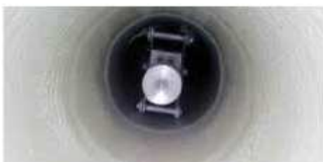
Pred aplikáciou, počas aplikácie a po aplikácii systému Belzona 1381 striekaním na vnútorný povrch potrubia
