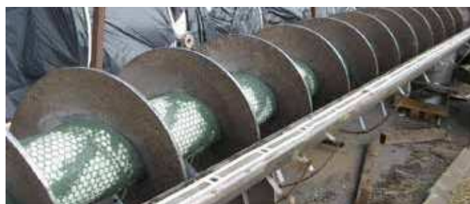
Závitovkový dopravník opravený pomocou náteru Belzona 1813 a hliníkových doštičiek
